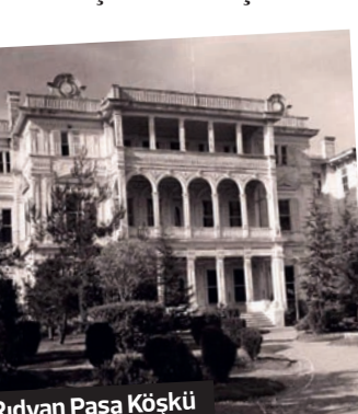
Rıdvan Paşa Köşkü
